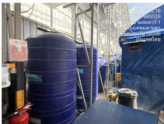
ภาพที่ 39 ถังสำรองน้ำใช้ในพื้นที่โครงการ
