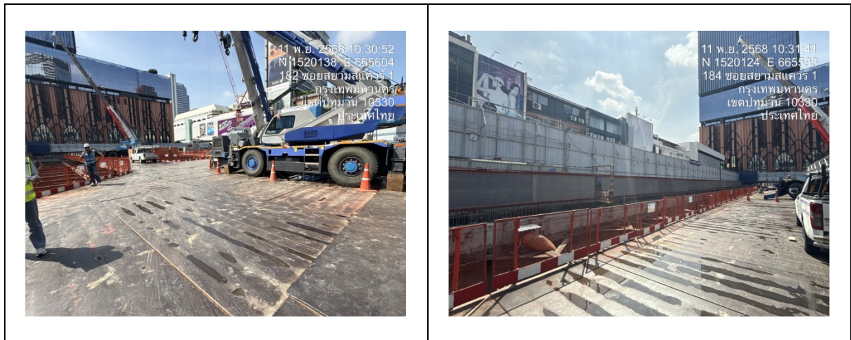
ภาพที่ 32 แผ่นเหล็กหนาบริเวณภายในพื้นที่โครงการ
